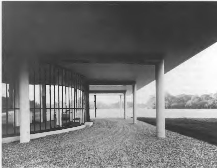
Εικ.7. Άφιξη των αυτοκινήτων στα pilotis. Fig.7 .Arrival of the automobiles under the pilotis. Le Corbusier, Poissy: Villa Savoye 1928 © FLC/ADAGP L2(17)23
