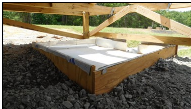
(g) effluent collection platform
